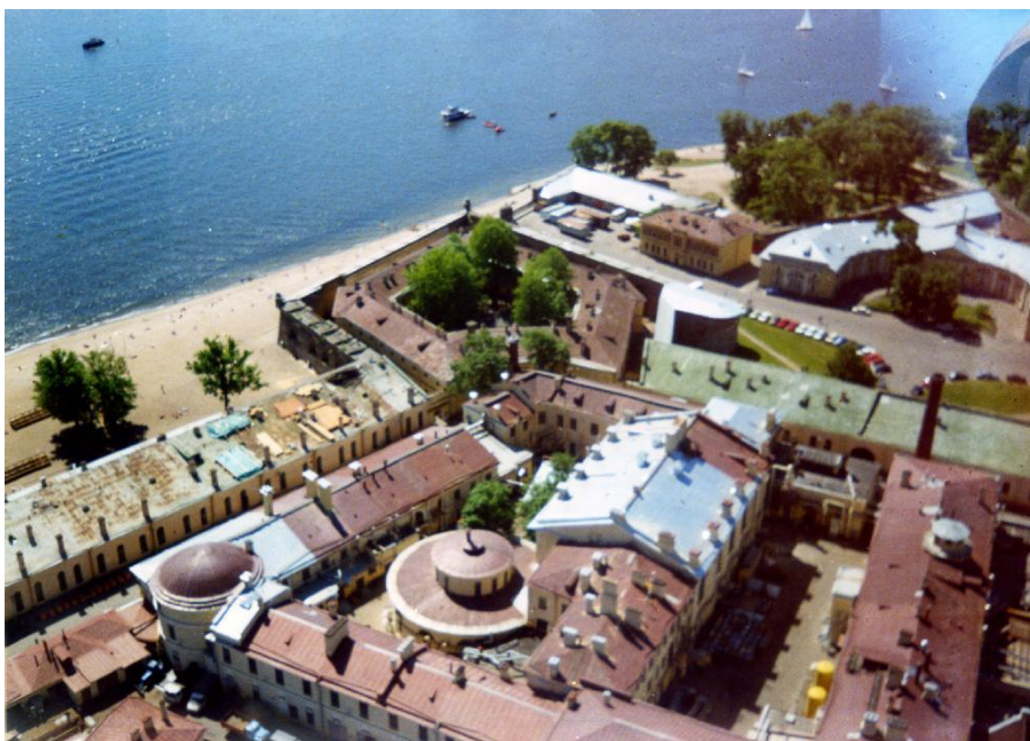
Fot. 3. Areszt Śledczy Bastionu Trubeckiego
